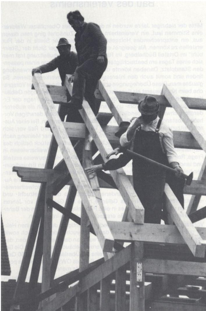
Innerhalb weniger Stunden wurde das Grundgerüst errichtet und die Dachkonstruktion konnte aufgebaut werden.
