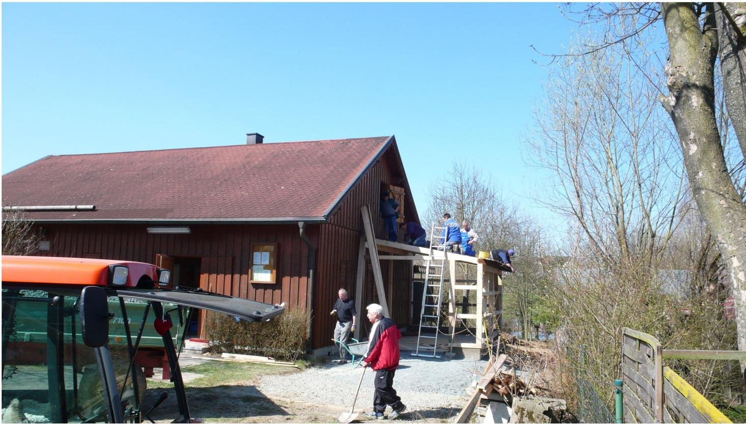
Nach dem Heben der Konstruktion wurde diese an dem Wanderheim befestigt und die Dachlattung konnte aufgebracht werden.
